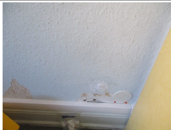
Prélèvement - P014 : RDC / B1 LOGE COURRIER - Enduit- (Présence d'amiante)
