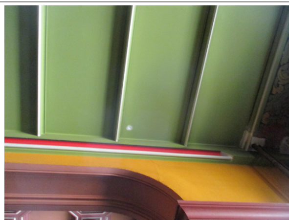
Prélèvement - P006 : N1 / 114 AUDIENCE - Enduit- (Absence d'amiante)
