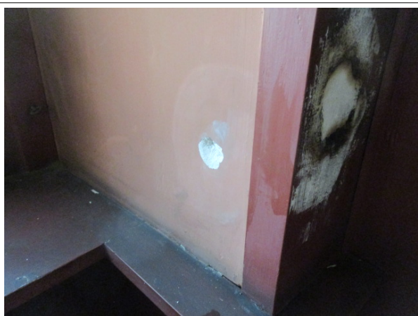
Prélèvement - P005 : N1 / 114 AUDIENCE - Enduit- (Absence d'amiante)
