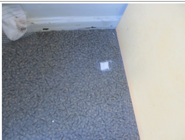
Prélèvement - P011 : RDC / B1 LOGE COURRIER - Colle- (Absence d'amiante)
