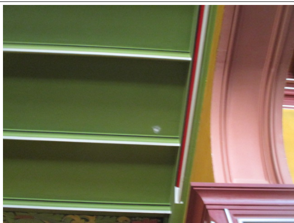
Prélèvement - P007 : N1 / 114 AUDIENCE - Enduit- (Absence d'amiante)
